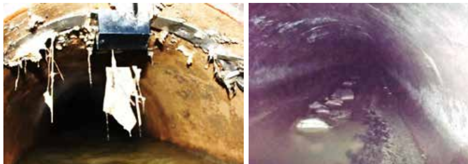
Acumulação de lixo no suporte do sensor
