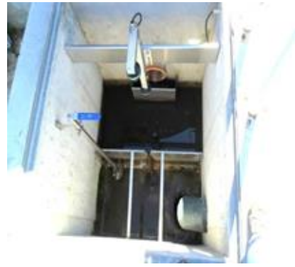
Medidor ultrassónico de nível aplicado num descarregador
