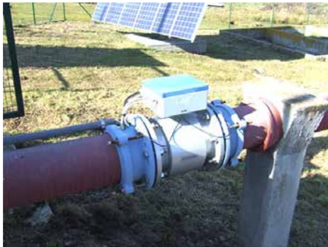
Figura 5-72 – Caudalímetro electromagnético para condutas parcialmente cheias, utilizando o efeito capacitivo, instalado à entrada de uma pequena ETAR 23
