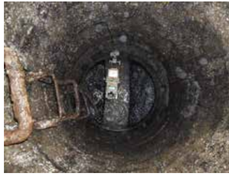
Figura 9-39 – Medidor de caudal depois da limpeza
