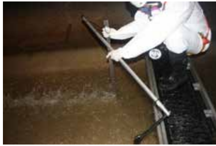
Figura 9-24 – Verificação de nível com régua
