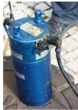
Figura 9-41 – Isolamento dos cabos de ligação do medidor ao "datalogger"
