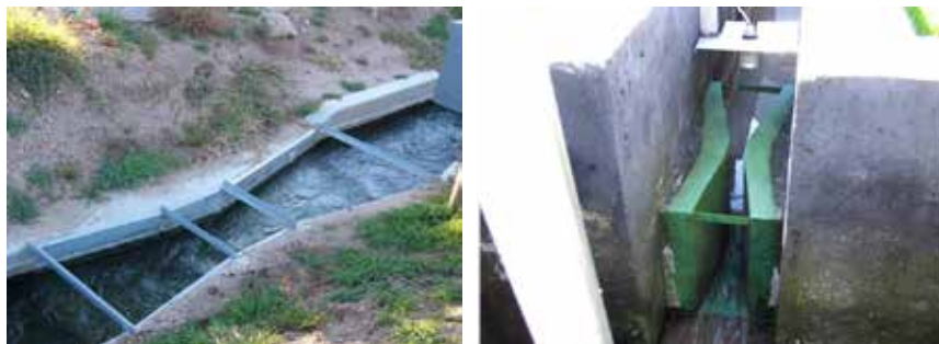
Figura 5-64 – Caleiras “Parshall” pré-fabricadas depois de montadas no local. (observam-se os tirantes que ficaram mesmo após a montagem)
