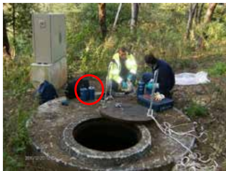
Figura 9-42 – Substituição de baterias num medidor de caudal portátil
