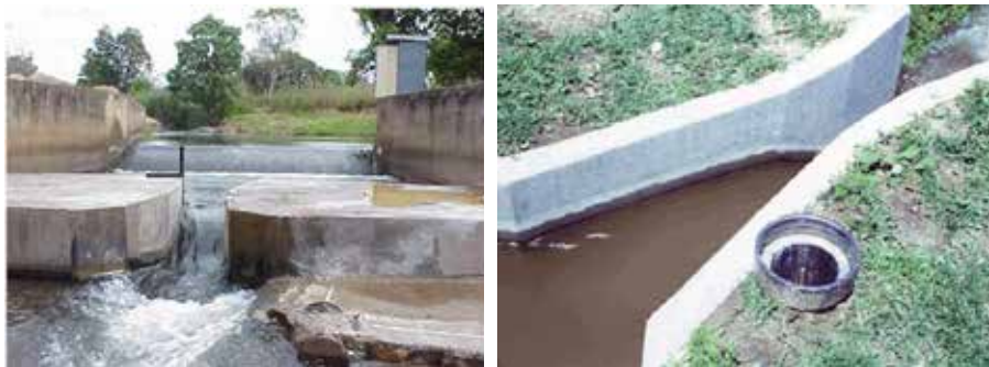
Figura 5-62 – Caeiras “Parshall” em betão armado no local. Na da direita nota-se o poço de medição
