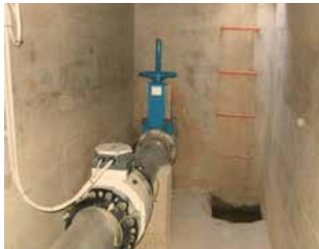
Caudalímetro electromagnético de secção parcialmente cheia
