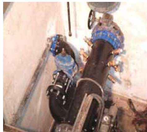
Caudalímetro ultrassónico por medição do tempo de trânsito
