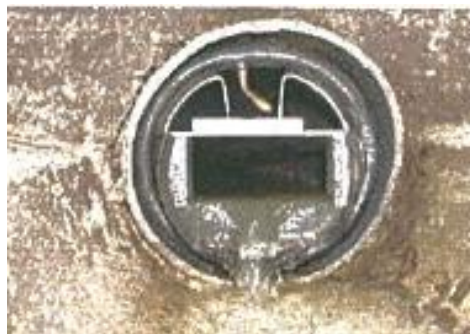
Figura 9-36 – Descarregador graduado instalado no coletor
