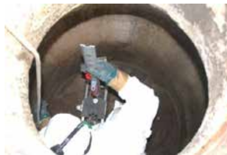
Medição de nível com régua
