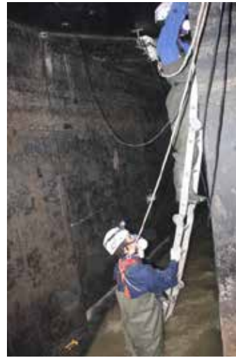
Figura 9-31 – Recurso a um ponto de ancoragem durante os trabalhos no interior do coletor
