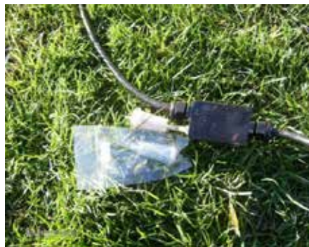
Figura 9-43 – Substituição dos filtros de sílica
