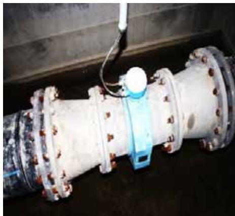
Caudalímetro electromagnético de secção cheia
