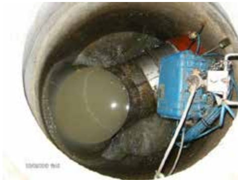
Caudalímetro electromagnético do tipo cachimbo
