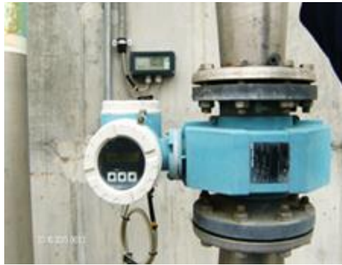
Caudalímetro electromagnético de secção cheia
