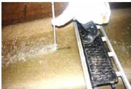
Medição de velocidade com vara portátil
