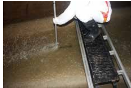
Figura 9-25 – Verificação de velocidade com vara portátil
