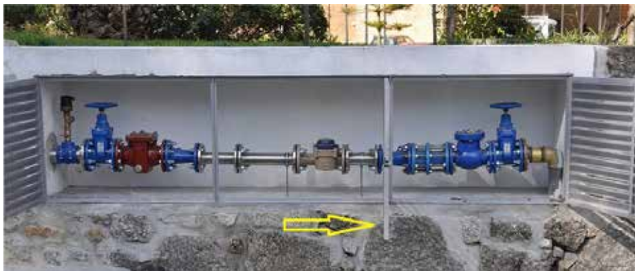
Figura 6-21 – Condições reais de instalação de um grande contador 29
