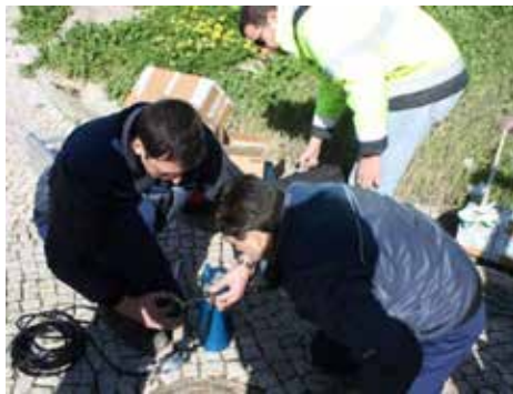
Figura 9-40 – Visita de campo para manutenção preventiva de um medidor de caudal
