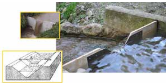
Figura 5-3 – Descarregadores de medição usados nos tempos modernos
