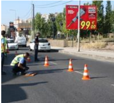
Figura 6-37 – Instalação na faixa de rodagem (implica policiamento e desvio de trânsito)
