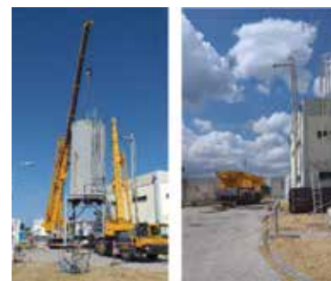
Desmontagem do Silo Existente
