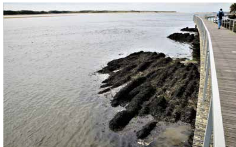
Passadiço no estuário do Cávado, em Esposende, junto à margem norte do rio. Através desta ecovia é possível observar “um grande repositório sobre a biodiversidade do Parque Natural, seja em terra, no mar e no ar”.
