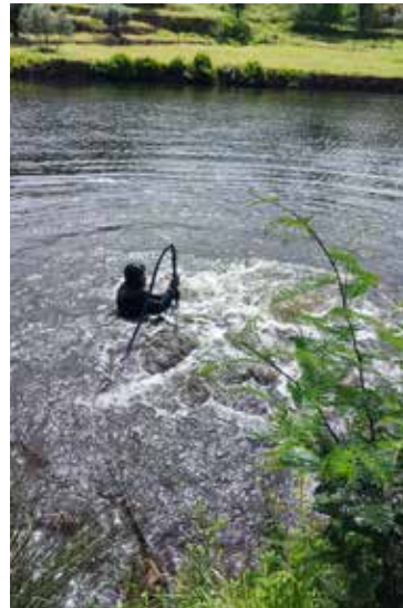
Figura 5. Fase de injeção de ar no subleito do rio
