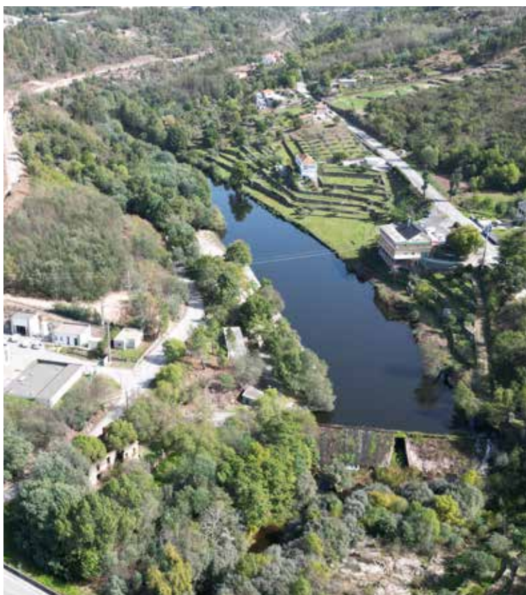
Figura 1. Vista aérea da ETA e do açude de Ponte de Juncais
