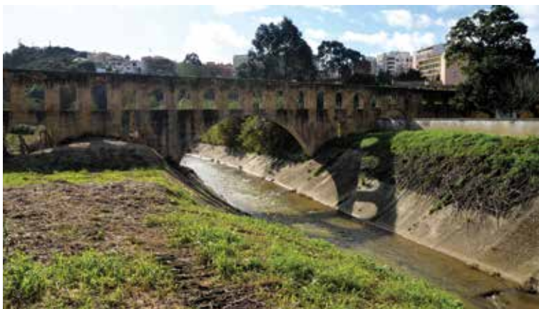
Travessia do aqueaduto dos Canos sobre o Sizandro. Antes de chegar à cidade de Torres Vedras, a arcaria atinge 8 metros na sua maior altura, integrando o arco mais largo, precisamente sobre o curso do rio, com 12 metros de envergadura.
