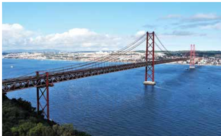
O Tejo, antes de desaguar no oceano, é atravessado pela Ponte 25 de Abril (inaugurada em 1966). Esta travessia, com 2 277 metros de comprimento e 190,47 metros de altura (das torres principais acima do nível da água), é considerada uma das maiores pontes suspensas da Europa
