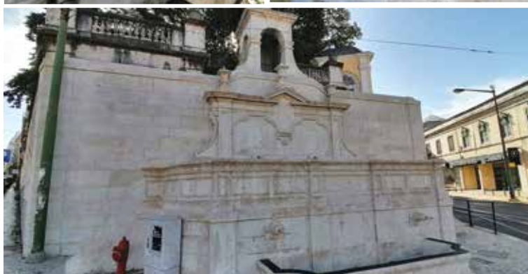
Chafariz do Rato – Antes e depois da intervenção de conservação e restauro
