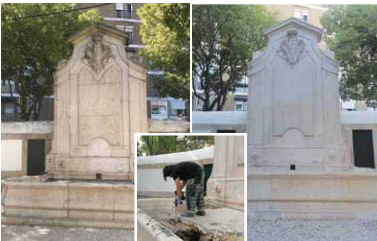
Chafariz de Benfica – Antes e depois da intervenção de conservação e restauro Na demolição de laje em betão existente na bacia foram descobertas as bases de lioz maciço originais para apoiar os recipientes durante a recolha de água.
