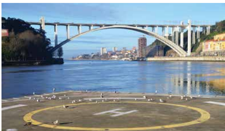
Vista da Ponte de Arrábida, a última travessia sobre o rio Douro, antes da sua chegada à foz. Na sua construção, iniciada em março de 1957, foram gastos cerca de 20 mil toneladas de cimento, 58.700 m 3 de betão armado e 4450 toneladas de aço.
