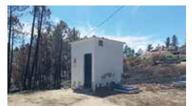
Instalação de tratamento e Furo de Casais do Vento
