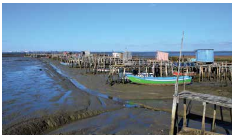
Vista dos cais palafitas da Carrasqueira, considerados os mais notáveis e icónicos. As estruturas de acossagem, construídas sobre estacas de madeira, permitem aceder às embarcações mesmo na maré baixa.
