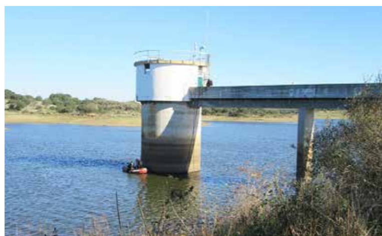
Inspeção dos elementos exteriores da Torre de Captação
