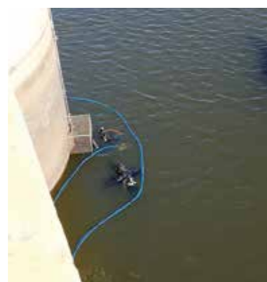
Registo de vídeo em circuito fechado com visualização através de monitor à superfície; verificação da condição física da grade de proteção da entrada de água à cota 192,50 m e do pilar
