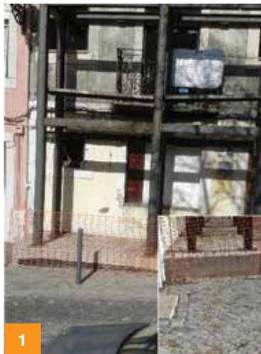
1 Maciço de contenção da fachada sobre a conduta, o que impossibilita o acesso rápido à mesma
