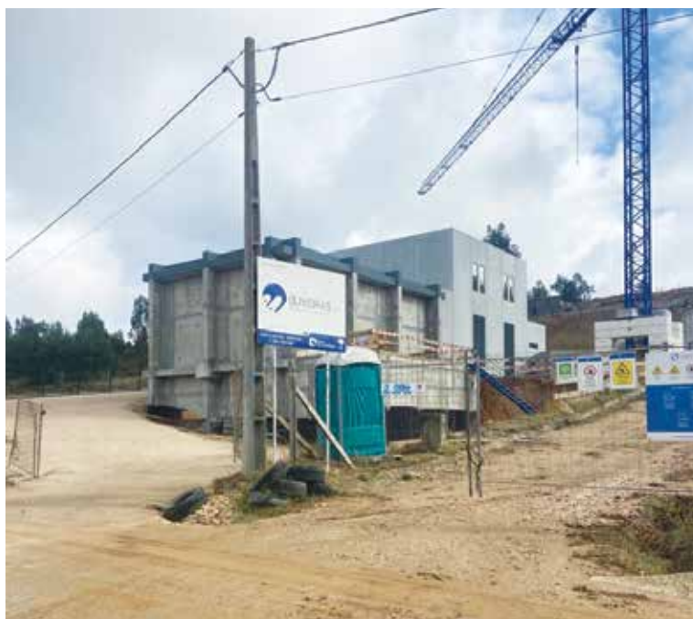
Construção Mini-hidroelétrica da Estação de Tratamento de Água da Asseiceira
