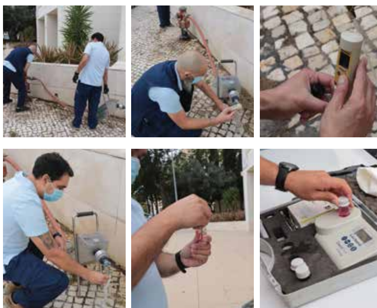
Ação de descarga e determinação de parâmetros de qualidade da água na rede de Lisboa
