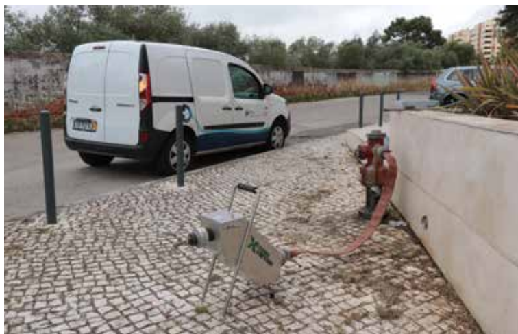
Ação de descarga e determinação de parâmetros de qualidade da água na rede de Lisboa
