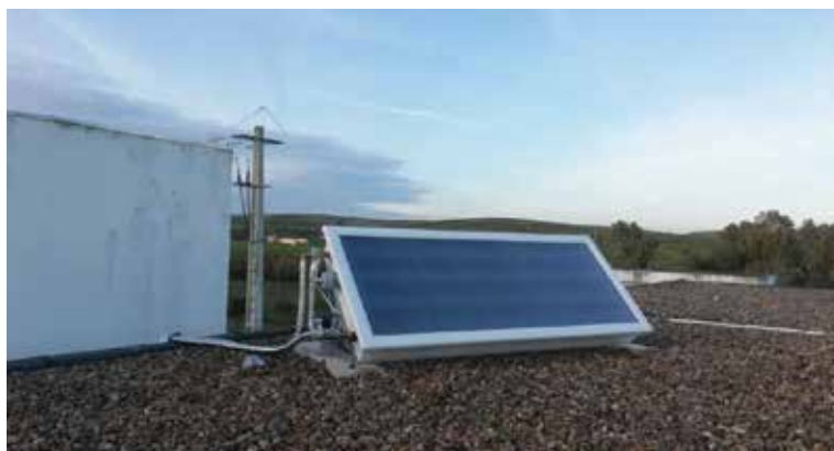
ETA do Caia
