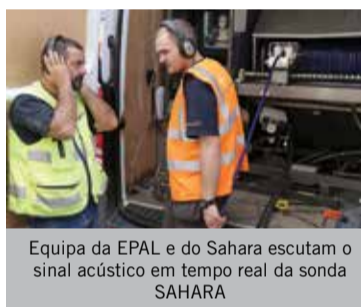
Inserção da sonda acústica na conduta a inspecionar
