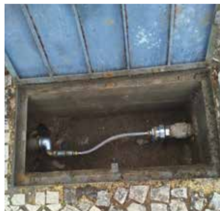
Junta de ligação antes e depois da reparação
