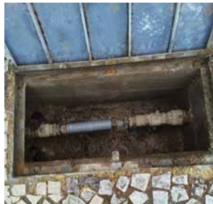
Junta de ligação antes e depois da reparação
