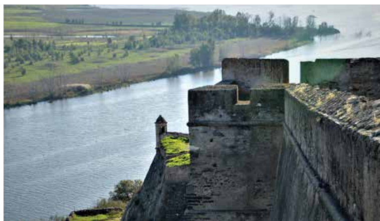
Durante séculos o conjunto de monumentos constituído pelo Castelo e a pela Fortaleza de Juro-menha, classificado como Imóvel de Interesse Público, ocupou a função de sentinela do rio Guadiana
