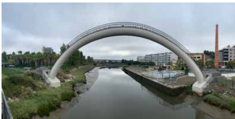
Ponte Sifão do Aqueduto Tejo durante e após conclusão da intervenção
