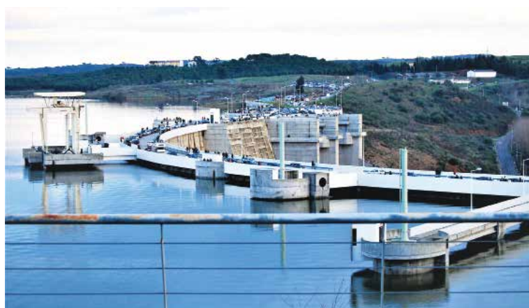
A 12 de Janeiro de 2010 o nível de água armazenada atingiu a cota máxima de 152 metros, um metro abaixo do nível de máxima cheia para que a albufeira está preparada. Trata-se de um volume de água armazenada de 4 150 000 000 m 3
