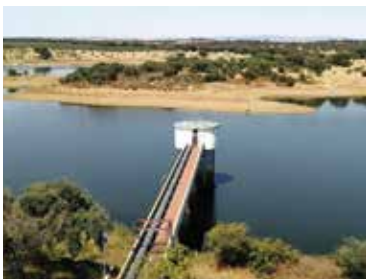
Torre de Captação de Monte Novo
