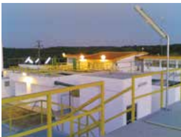
ETA de Monte Novo
