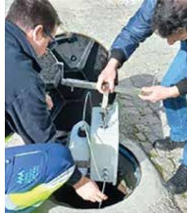
Figura 2. Instalação de equipamentos de recolha de amostras.
