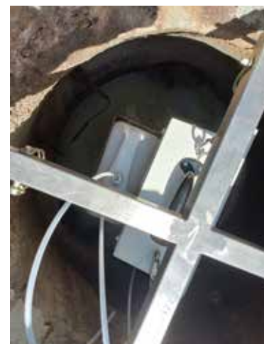
Amostrador de qualidade, colocado numa câmara de visita da rede em "baixa" de Gáfete
