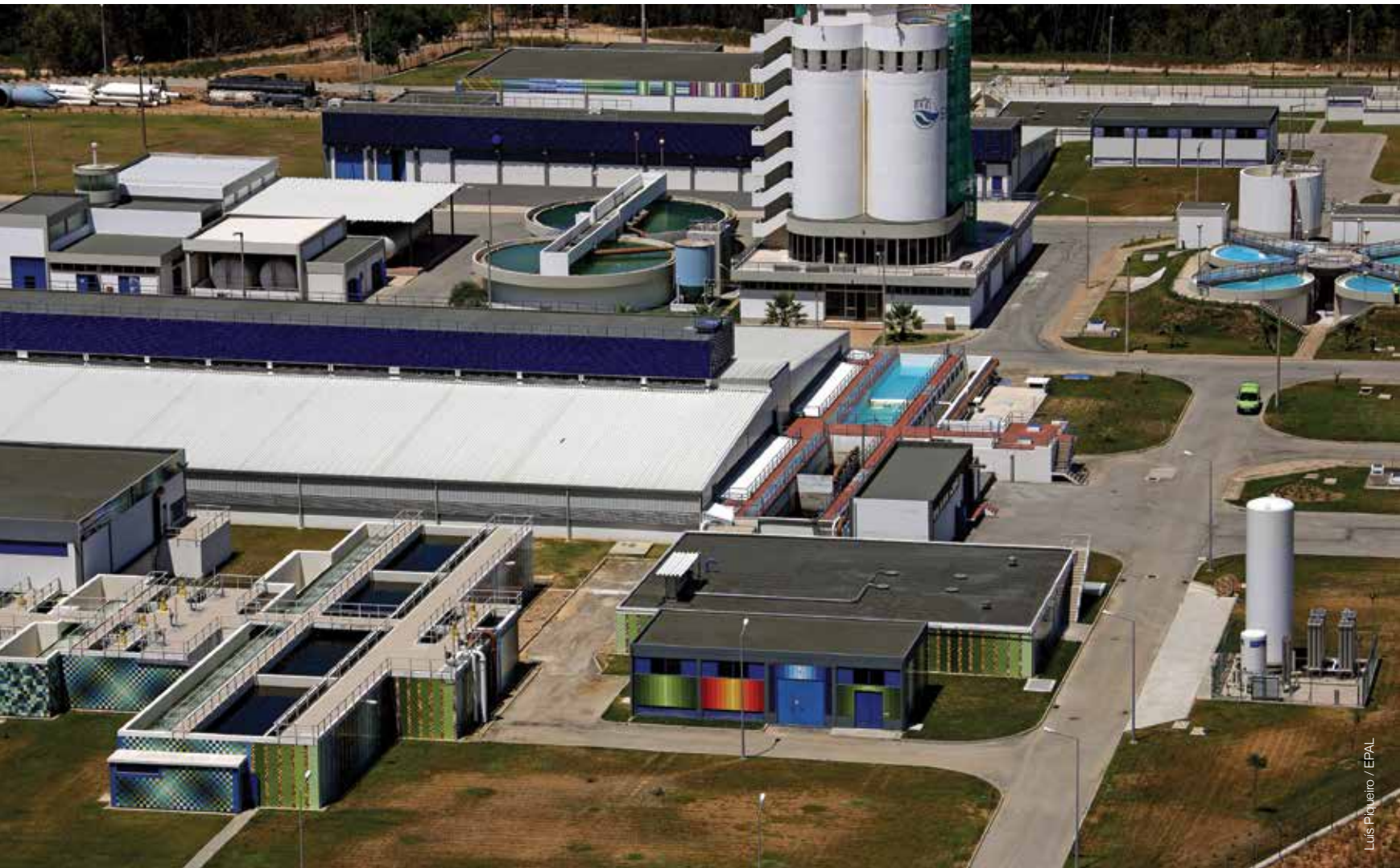
3500 m 2 Execução e assentamento dos elementos cerâmicos: Molde Cerâmicas, SA
