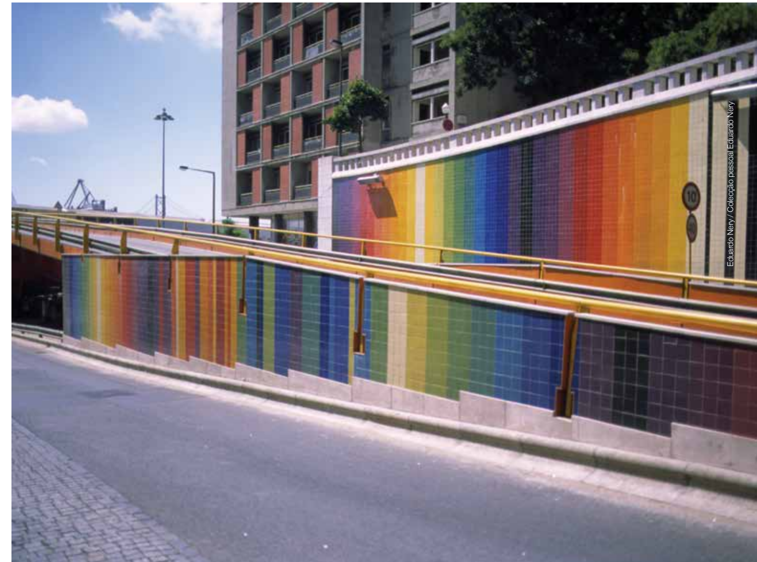
Viaduto, Av. Infante Santo, Lisboa 2000-2002
