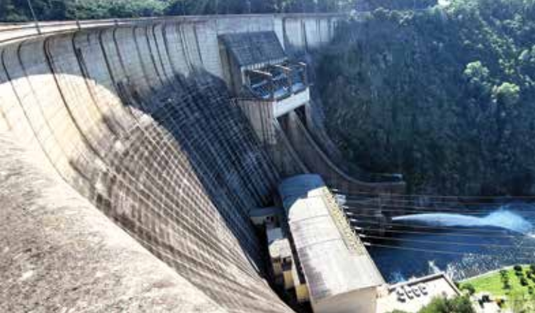
A Barragem de Castelo do Bode, inaugurada em 21 de janeiro de 1951, tem 115 metros de altura, sendo uma das construções mais altas existentes em Portugal. A água da sua albufera é utilizada na produção de energia elétrica, na defesa contra as cheias e no abastecimento de água para consumo humano.
