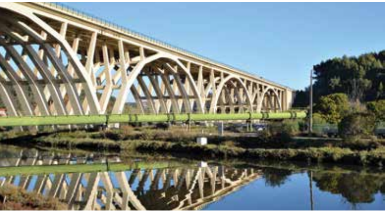
O viaduto sobre o rio Trancão, com cerca de 329 metros de comprimento, é constituído por 5 conjuntos de 6 arcos concêntricos, cada um com 57 metros. Muito próximo da sua arcaria foi construído, na década de 80, do século passado, o adutor Vila Franca de Xira-Telheiras, parte integrante do sistema de abastecimento de água do Castelo de Bode.
