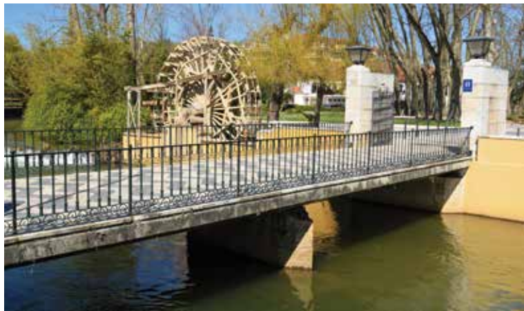
A nora, com cerca de 10 metros de diâmetro, foi feita em madeira de carvalho e de pinho. Este instrumento hidráulico, visto como um bom exemplo de arte e de engenho, carregava através do seu movimento rotativo, vários alcatruzes de barro, cada um com a capacidade de 5 litros de água.
